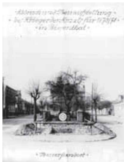
Neuaufstellung des Kriegerdenkmals. Noch steht die Veranda. Der Zaun mit den Pfeilern ist auch noch erkennlich. Nur die Tankstelle ist nicht mehr sichtbar. Aufnahme August 1938
